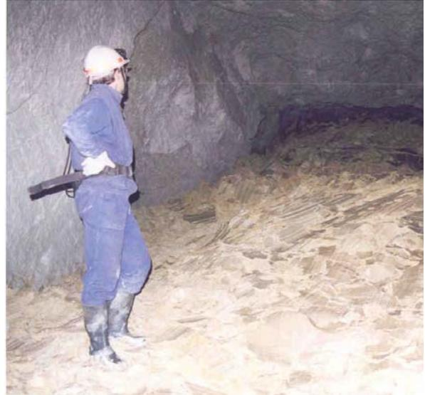
*Figure 8 : Cône d'éboulis (à gauche : marnes sèche, à droite : le même matériau sous l'effet de l'eau)*
