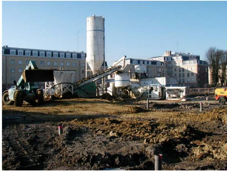
*Figure E : Chantier d'injection de coulis à base de ciment dans une carrière de craie (Valenciennes, Nord)*
