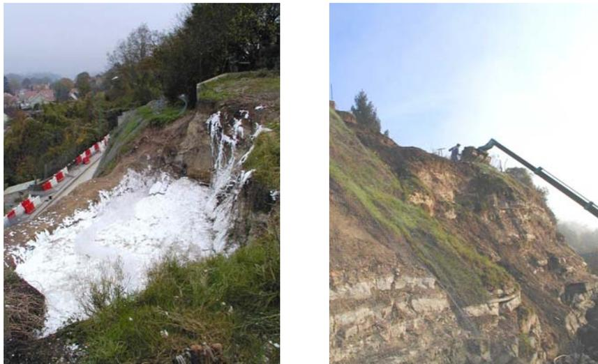
*Figure 15 : Remplissage d'un fontis par de la mousse thermodurcissable et mise en place d'une couverture végétale (Conflans Ste-Honorine, Val-d'Oise)*
