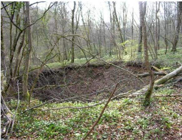
*Figure A : Effondrement localisé au droit d'une ancienne mine de fer de Lorraine*
