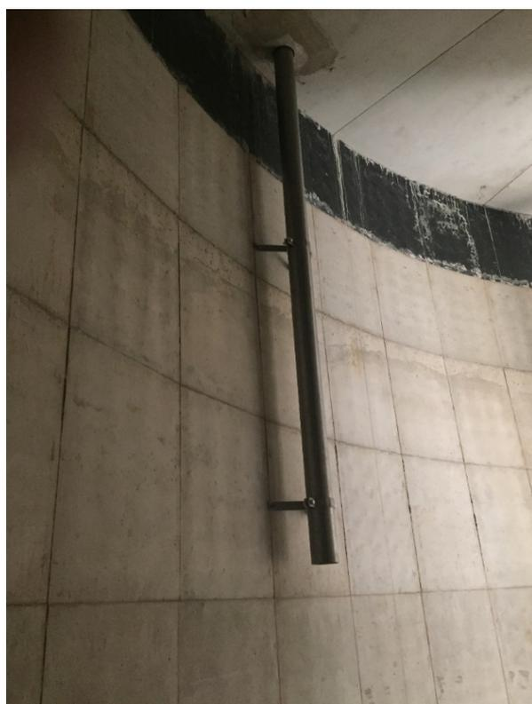
Figure 2 : Tuyau vertical dirigeant le lisier sous le matelas
