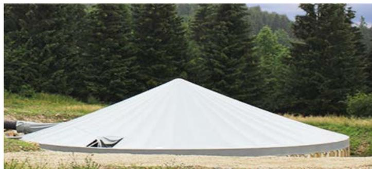
*Figure 13 : Couverture avec mât central (Source : <http://www.isotent.fr>)*
