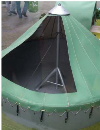
*Figure 12: Maquette de la structure d'une couverture avec mât central (société SOFAREB) (Source : INERIS°)*
