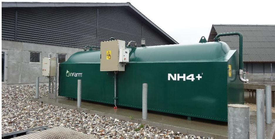
Figure 6: Citerne de stockage d'acide sulfurique pour acidification au bâtiment (Source :: INERIS).
