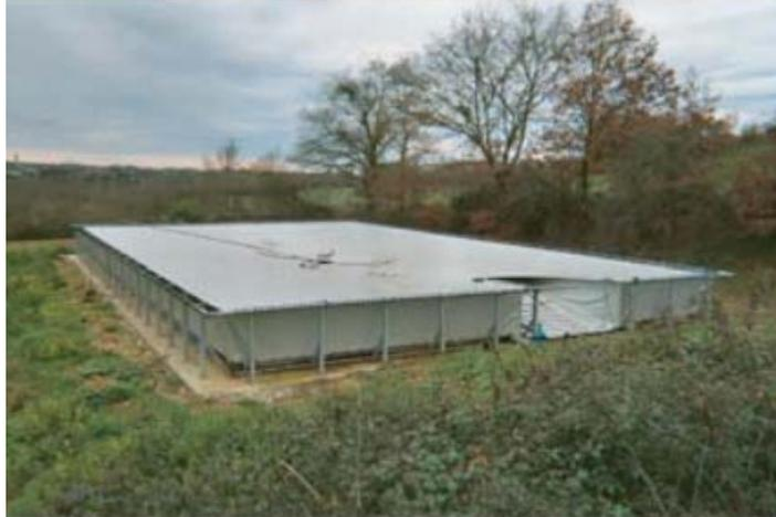
Figure 14 : Couverture tendue à plat (Source : <http://www.landes.chambagri.fr/>)
