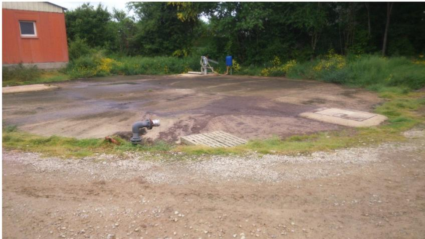
*Figure 15: Fosse enterrée avec couverture rigide (Source : INERIS)*
