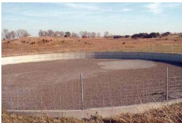
*Figure 9: Couverture de fosse à lisier composée d'argile expansée.
