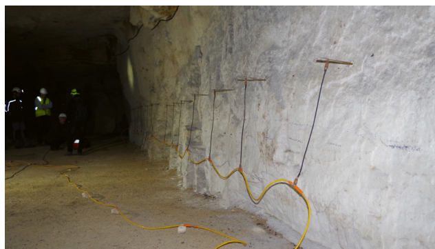
Figure 14 : auscultation par imagerie électrique d'un pilier dégradé (Cerema).
