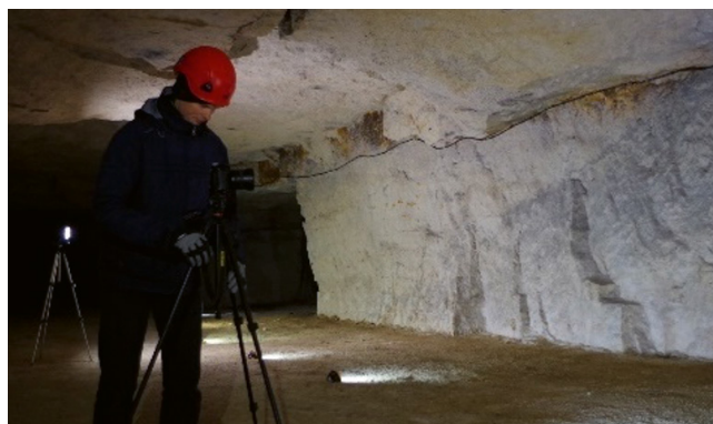
Figure 12 : levés par photogrammétrie d'un pilier dégradé (Cerema).
