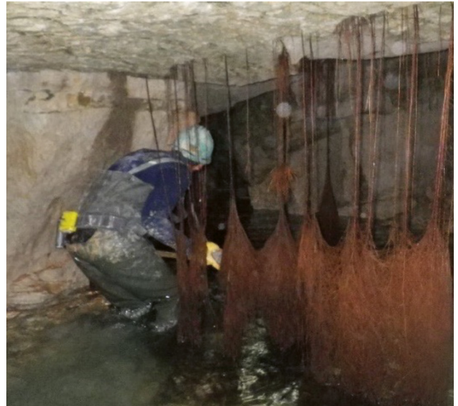
Figure 8 : développement de racines dans une carrière abandonnée partiellement ennoyée.
