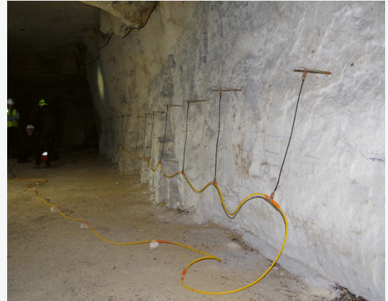
Système d'acquisition électrique sur un pilier.
