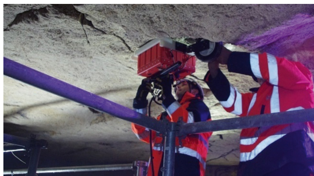
Figure 13 : auscultation par radar géologique du toit d'une cavité (Cerema).
