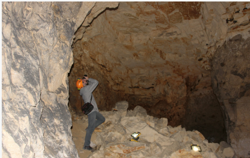
Exemple de mise en œuvre de la photogrammétrie pour une montée de voûte.
