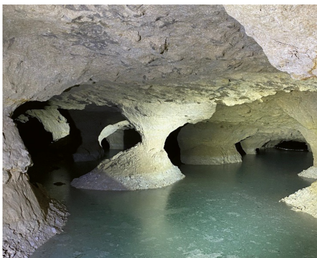
Figure 5 : piliers en diabolo dans une ancienne carrière.
