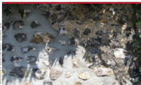
Rejointoiement de la maçonnerie d'un parement
