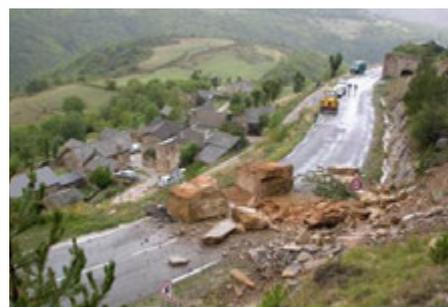
**Éboulement** de gros blocs sur route en Lozère. Dommage fonctionnel à structurel pour la voirie.
