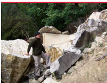
Exemple de dommages causés par la chute de blocs rocheux (volumes de 1 à 2 m<sup>3</sup>) sur un réservoir d'eau en béton armé, Foulayronnes, Lot-et-Garonne.
