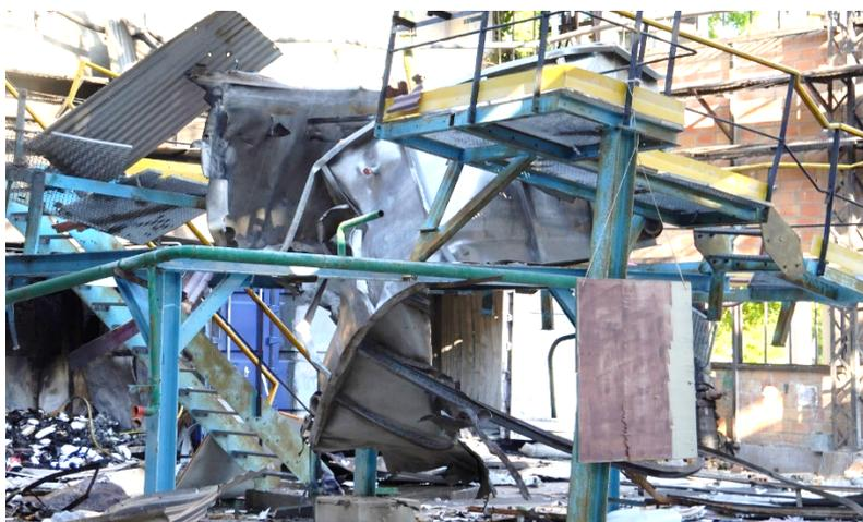
Figure 18 : Dommages subis par la cuve non raccordée
