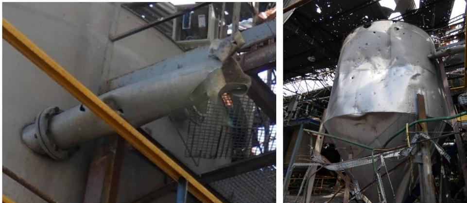
Figure 17 : Rupture de la tuyauterie entre la cuve « eaux blanches » n°2 et le décanteur et perforation de celle-ci (à gauche) et déformation et nombreuses perforations du décanteur (à droite)
