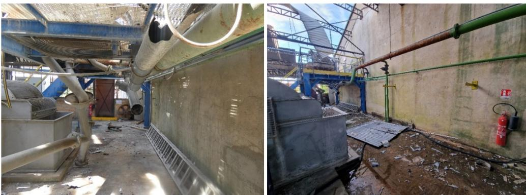
**Figure 16 : Rupture sur tout le long de la canalisations PVC reliant les tamiseurs à la cuve « eaux blanches » n°2**
