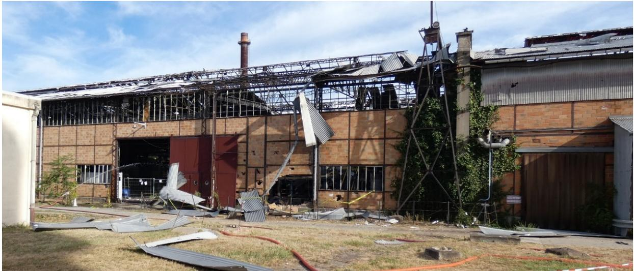
*Figure 5 : Dégâts en façade Sud du bâtiment*
