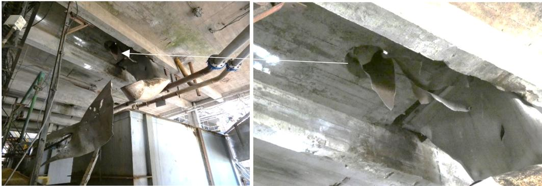
**Figure 14 : Endommagement des battants et rupture de la vitre du bac de récupération 2 et rupture de la canalisation reliant ce bac aux tamiseurs**
