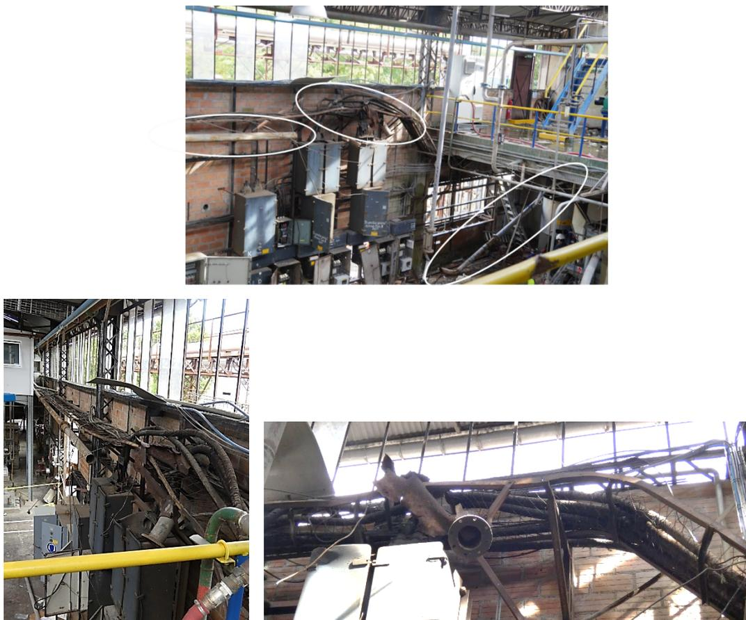
**Figure 13 : Rupture de la canalisation DN150 reliant la cuve « eaux blanches » n°1 à l'épauissiseur 3**
