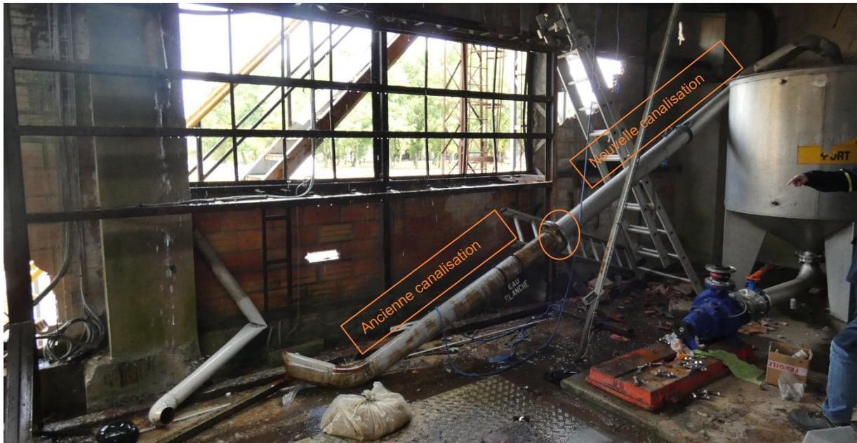
Figure 3 : Photo post accident de la canalisation en cours de raccordement
