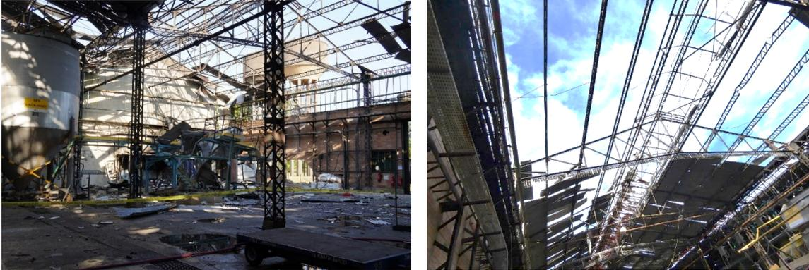
Figure 10 : Dégâts subis par la couverture de toiture – partie Sud
