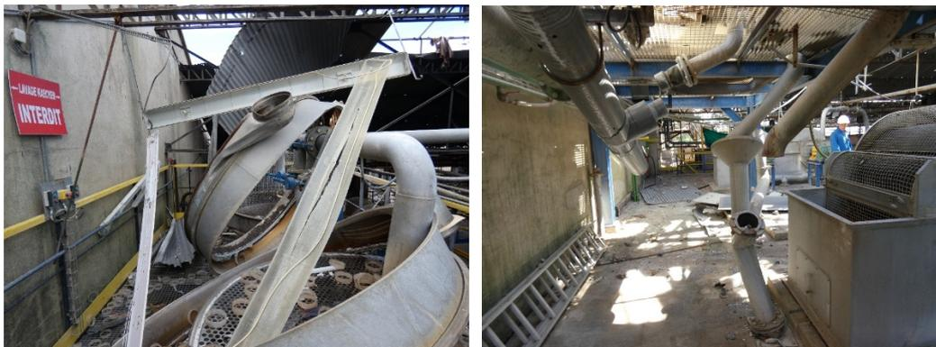
**Figure 15 : Endommagement des tamiseurs et des canalisations acier, PVC associées**
