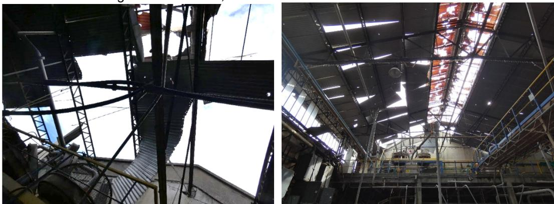
Figure 9 : Dégâts subis par la couverture de toiture – partie Nord
