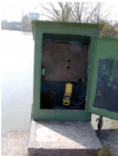
Photo n°12 : capteur radar installé dans le puits de mesure avant ajout des capteurs qualité.
