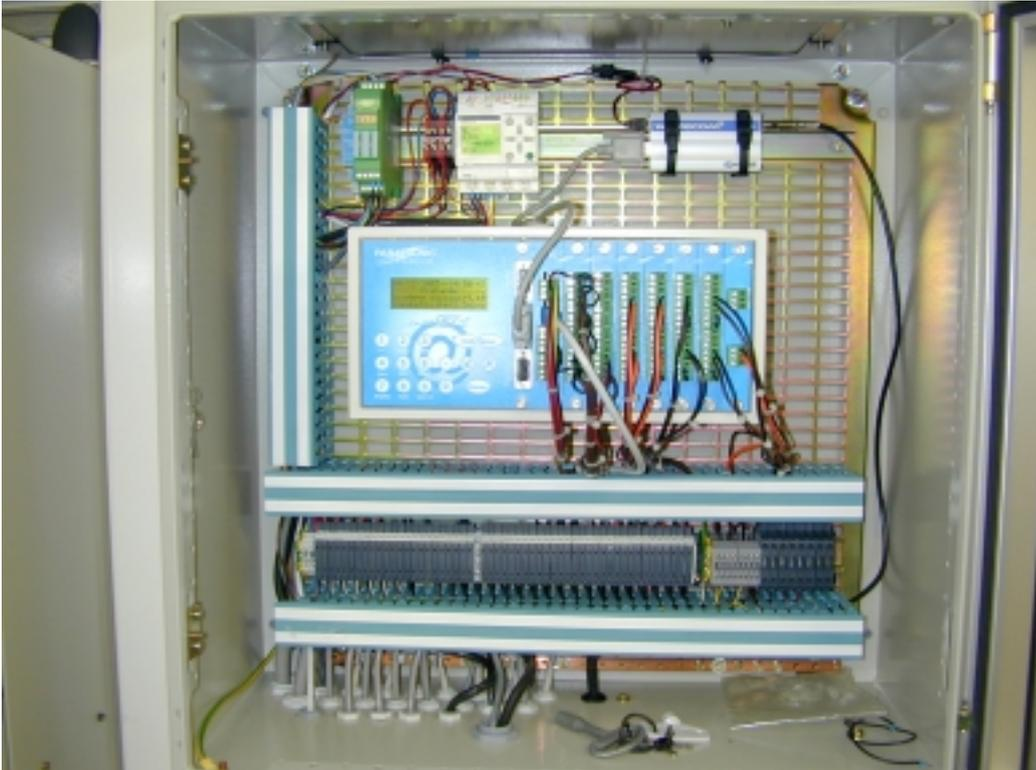
Photo n°18 : coffret du système d'acquisition de données
