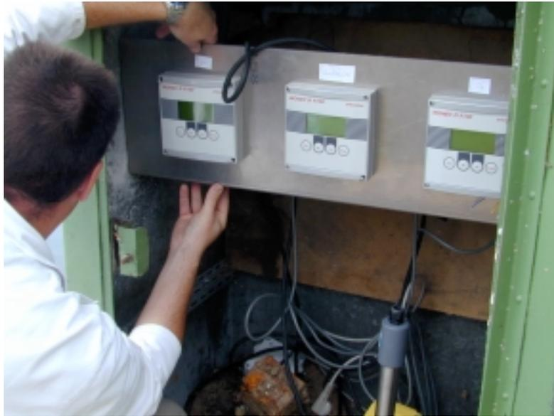
Photo n°13 : installation des 3 capteurs qualité dans la cabine du puits de mesure
