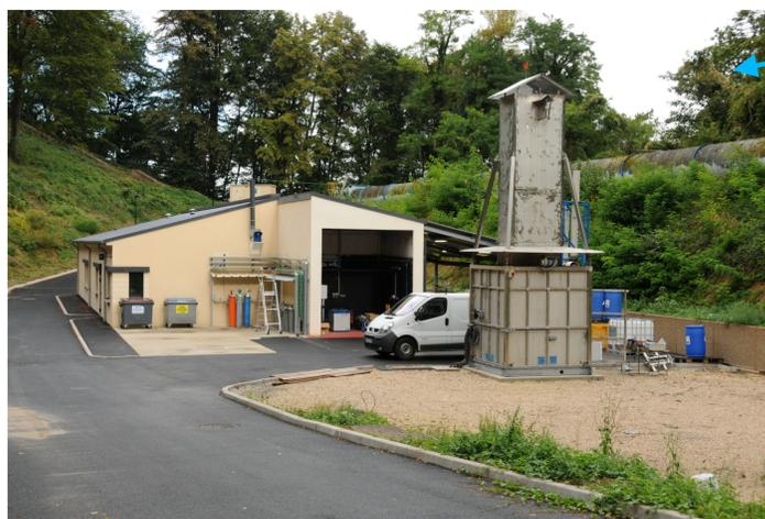
240 m<sup>2</sup> de laboratoires dédiés à la sécurité des batteries, avec des cellules d'essais sécurisées (surpression : 1 bar) Une installation de dépollution des émissions pendant les phases d'essai (unité de traitement de gaz)
