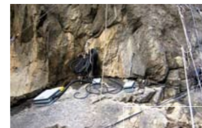
Station de mesure géotechnique installée sur le versant rocheux de Valabres.
