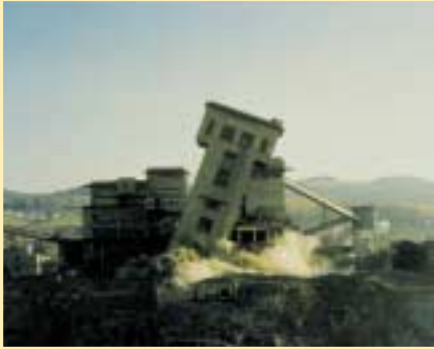
Torpillage d'une tour de mine.
