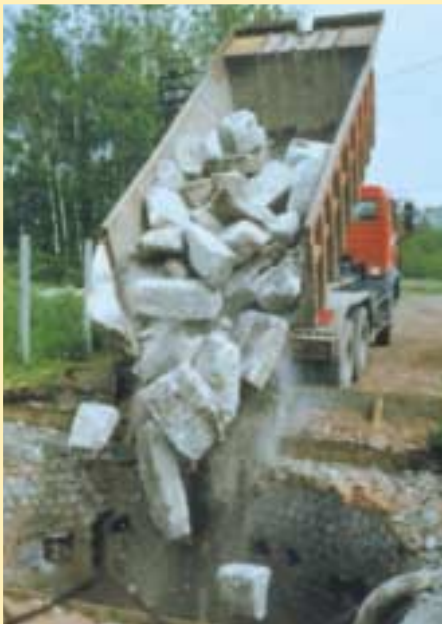
Remblayage gravitaire d'un ancien puits de mine.
