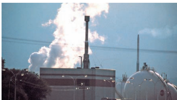
Directive phare de la réglementation européenne en matière de réduction des pollutions, la directive IPPC s'applique à environ 55 000 établissements en Europe et 8 000 en France.
