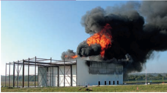
Projet FLUMilog, essai en grand d'incendie d'entrepôt.
