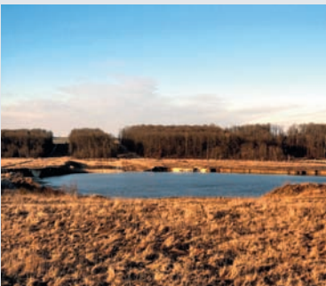
Effondrement d'une cavité souterraine à Cerville-Buissoncourt le 13 février 2009.
