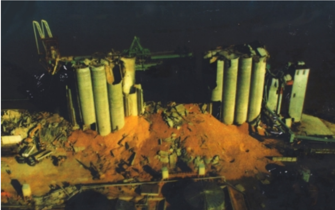
Figure 25 : vue de l'installation de stockage de Blaye après l'accident
