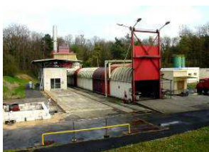
Galerie à incendie de 50 m pour réaliser des essais de combustion jusqu'à une puissance dégagée de 10MW (en maîtrisant les rejets dans l'atmosphère par une « tour de lavage »)
