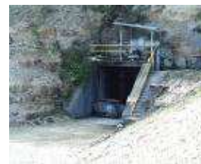
Chambre d'explosion 100 m 3
