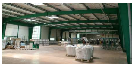
Figure 2 : Portique courant en profilés reconstitués soudés
