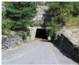
Galerie pour tests d'explosifs et essais d'explosion de poussières jusqu'à 150 b
