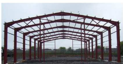
Figure 1 : Portique courant en profilés laminés à chaud
