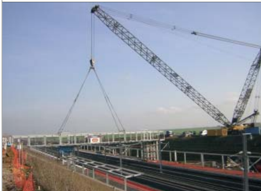
FABRICATION de la passerelle de Louvigny suivie par l'Institut de Soudure.
