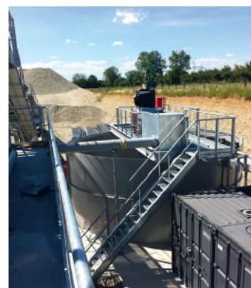
↓ Station de traitement des eaux de chantier, conçue par le groupe MS.
