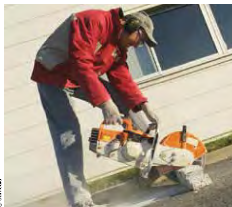
↑ Un disque diamant défectueux ou mal utilisé peut éclater et projeter des morceaux à 290 km/h.
