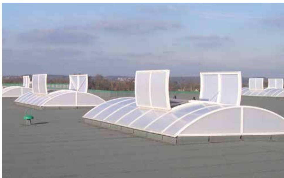
↑ La surveillance des produits de protection incendie est essentielle pour la sécurité des biens et des personnes. Ci-dessus : dispositifs d'évacuation naturelle de fumées et de chaleur.
