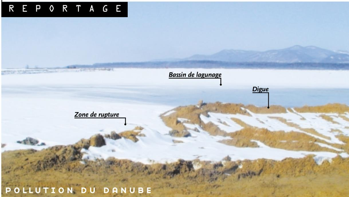
Quelques semaines après l'accident, l'équipe de l'INERIS s'est rendue sur le site de l'usine de traitements de minerai Aurul SA de Baia Mare. On distingue bien le bassin de lagunage, la digue en terre et la zone de rupture provoquée par les pluies diluviennes, à l'origine de la pollution.
