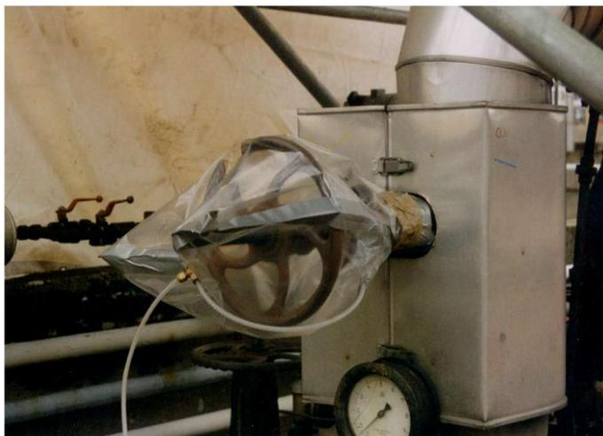
*Figure 1 : Exemple d'ensachage sur une vanne*
