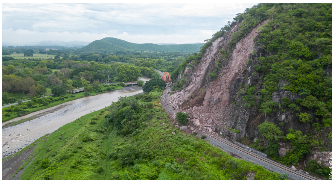
Figure 1 / Exemple d'éboulement sur une voie ferroviaire
