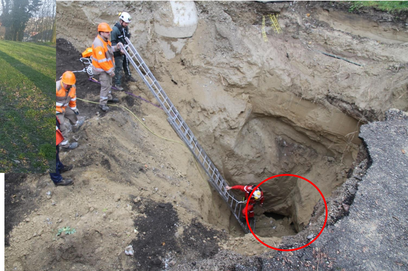
Galerie souterraine à 12 m sous la chaussée ©Pfastatt
