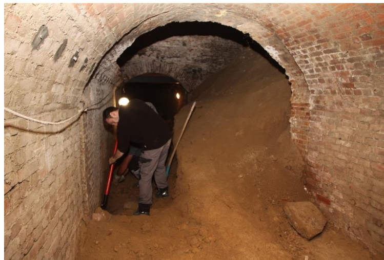
Travaux dans les galeries sous l'école ©Pfastatt
