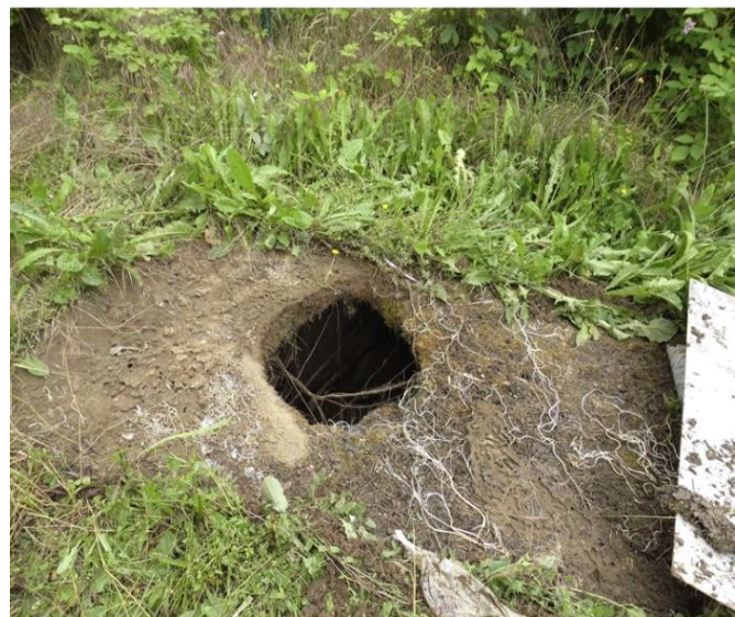
Inspection robotique d'une galerie ©BRGM
