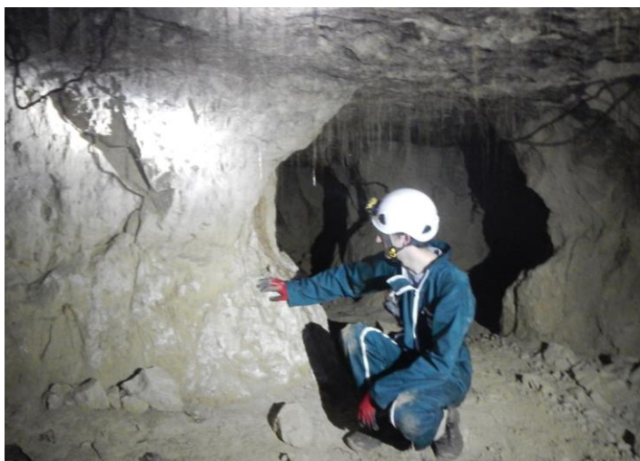
Visite de contrôle des galeries souterraines ©BRGM
