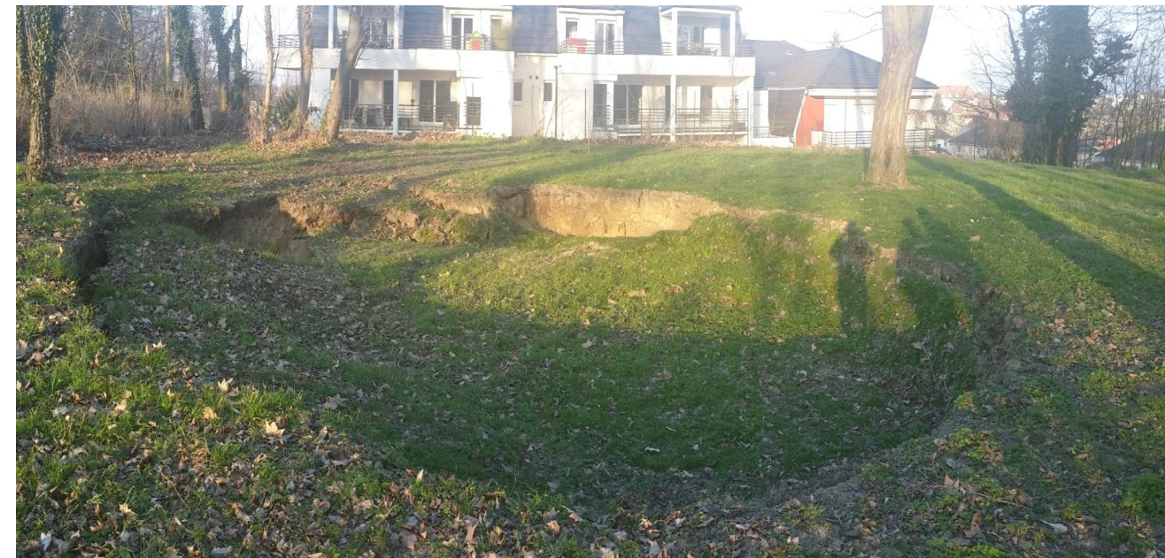
Affaissement de la rue d'Illzach ©Pfastatt
