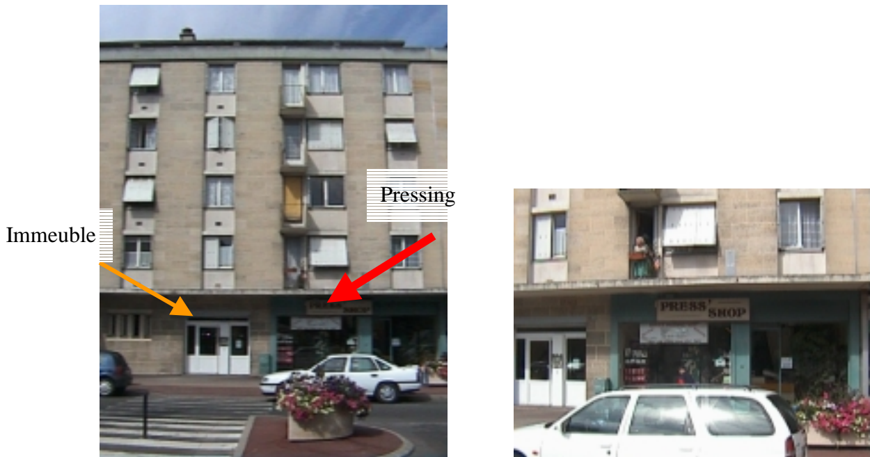
Figure 2 : Localisation du pressing de la campagne n°2
