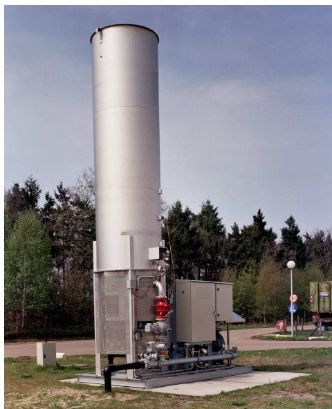
Figure 4 : Torchère à combustion interne
