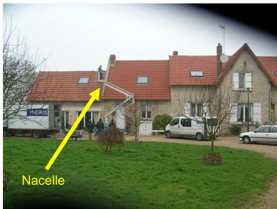
Figure A : Vue extérieure du logement
