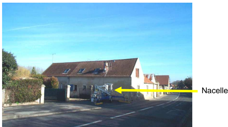
Figure C. Vue extérieure du logement
