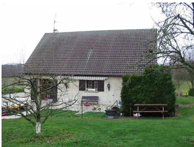
Figure E : Vue extérieure du logement
