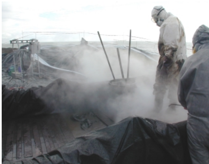
échantillonnage des HAPs durant le poste de « décontamination »
