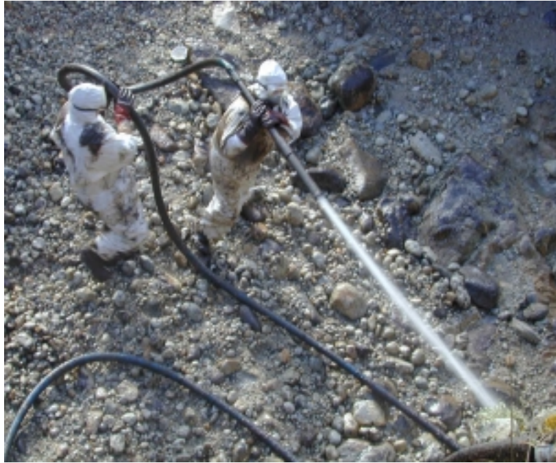
nettoyage de rochers à la lance impact
