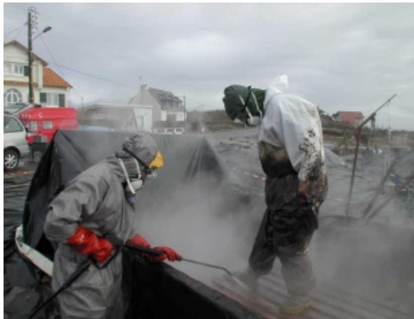
nettoyage des bottes
