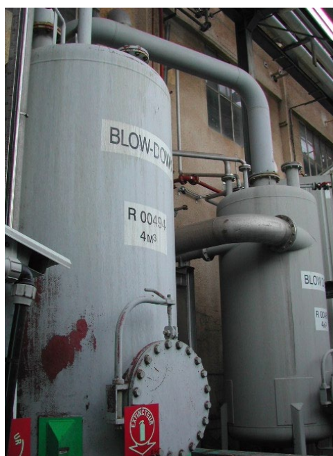
Blow down dédié au brome (Photo A. Barbero)
