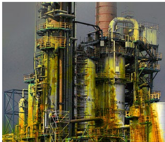
Vue d'une partie de l'usine de Griesheim après l'accident
