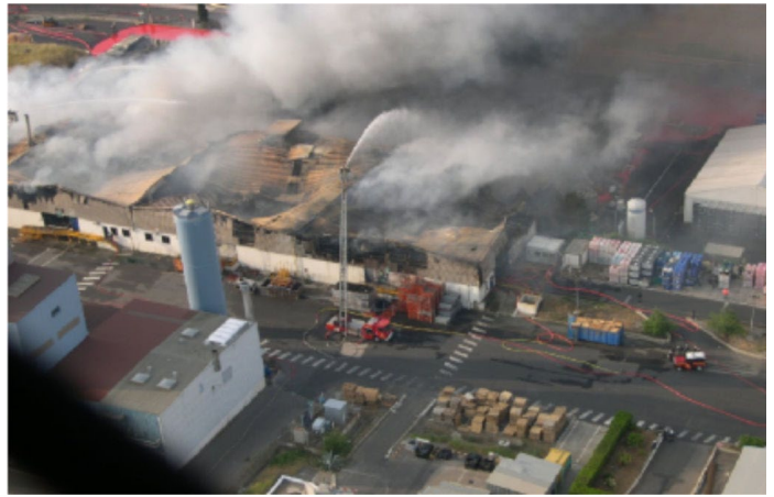
Incendie (usine agropharmaceutique) Source SDIS
