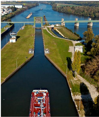
Figure 15 : Barrage de Port-Mort : injection d'oxygène dans l'eau du barrage 39
