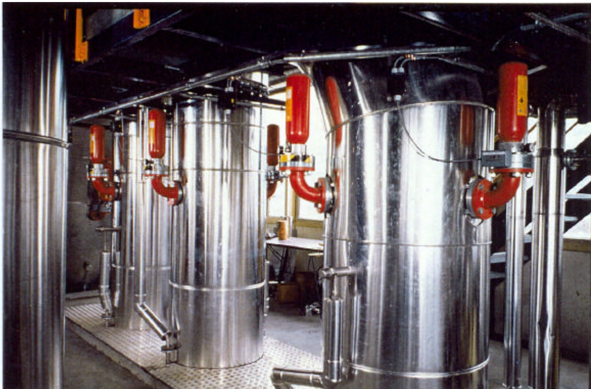
photo 7 : Exemple d'installation de trois barrières chimiques sur canalisations [02]
