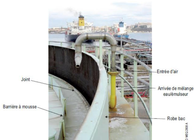
Figure 13 : Générateur fixe à mousse et barrière à mousse (Source : IFP Training)
