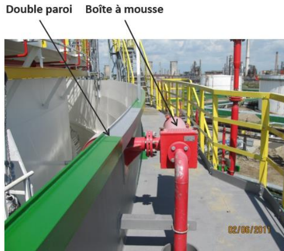
Figure 11 : Déversement de mousse dans l'espace annulaire (Source : IFP Training)
