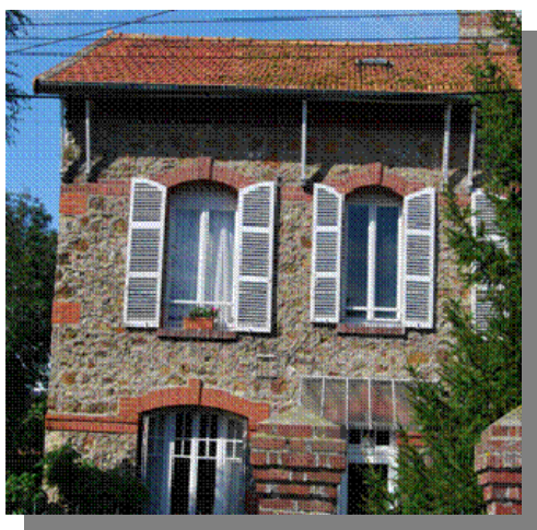
Figure 15 : Murs en moellons bruts lités (à gauche) ou moellons pour « opus incertum » (à droite), encadrements de fenêtres en briques (Source : CETE NC, INERIS)
