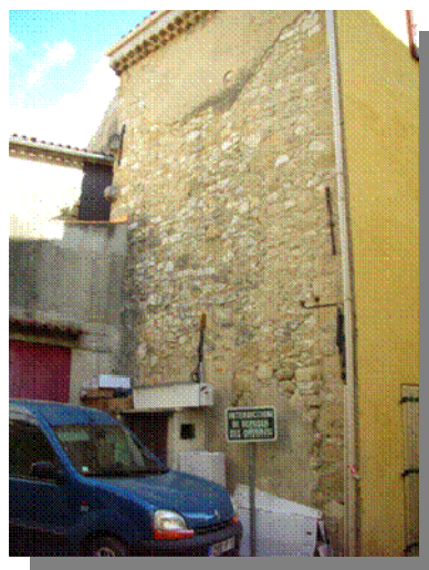
Figure 14 : Maçonneries en moellons (Source : CETE Méditerranée)
