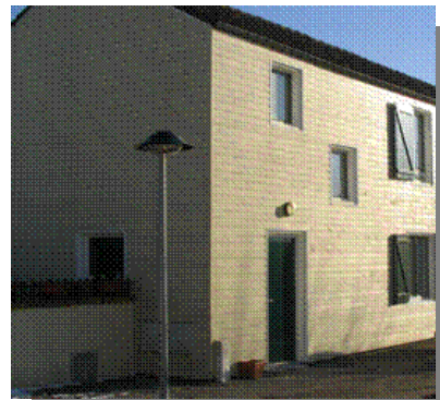
Figure 23 : Construction en lames de bois (Source : CETE NC)
