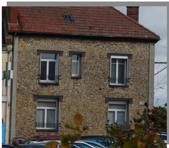
Figure 16 : Mur en moellons bruts ordinaires (Source : CETE NC, INERIS)
