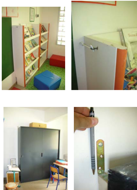
Figure 5 : Exemples de fixation d'armoires et d'étagères aux murs (Source : CETE Méditerranée)
