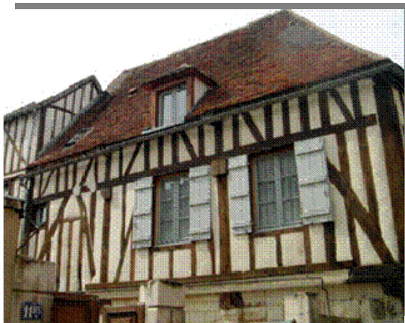
Figure 17 : Mur à pans de bois et remplissage en torchis ou en briques avec enduits. (Source : Internet)
