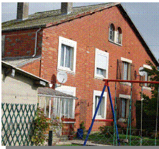
Figure 8 : Constructions en briques pleines (Source : CETE NC, INERIS)
