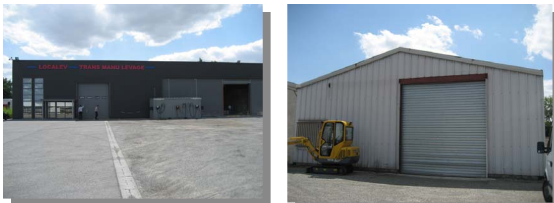
Figure 34 : Vues d'entrepôts métalliques (Source : INERIS)
