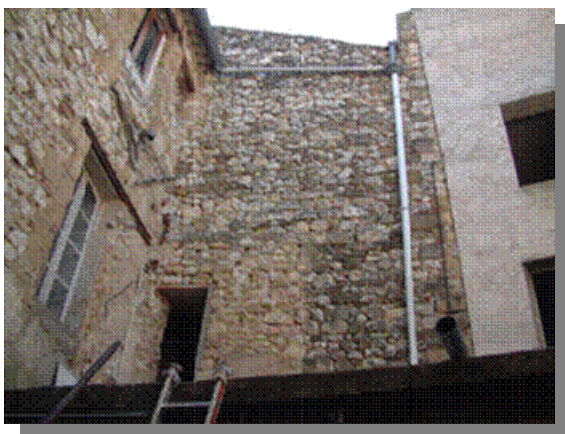
Figure 14 : Maçonneries en moellons (Source : CETE Méditerranée)
