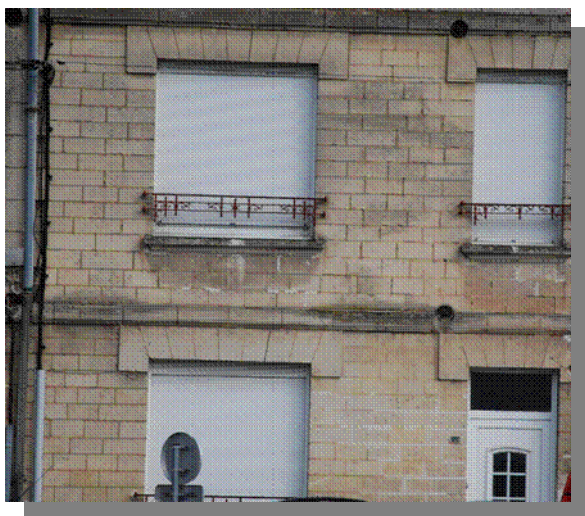
Figure 6 : Murs en pierres, blocs moyens (Source : CETE NC, INERIS)
