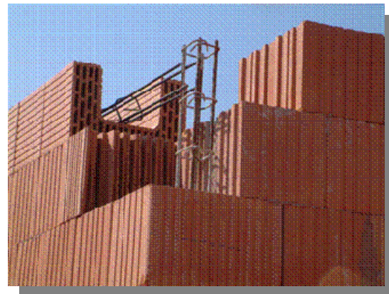
Figure 11 : Mur Vue d'une réalisation en cours d'un mur en brique creuse (Source : CETE Méditerranée)
