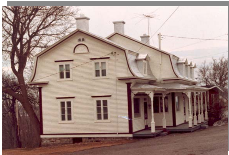
Figure 27 : Toiture à la Mansart (Source : Internet)
