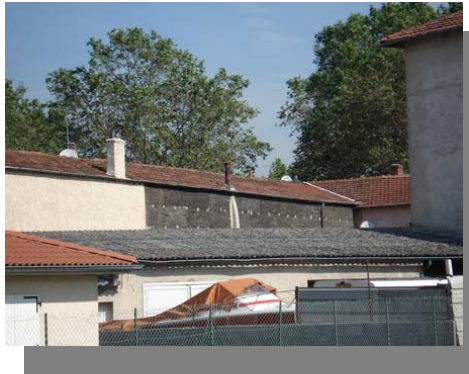
Figure 21 : Exemples de murs en pisé (Source : INERIS)
