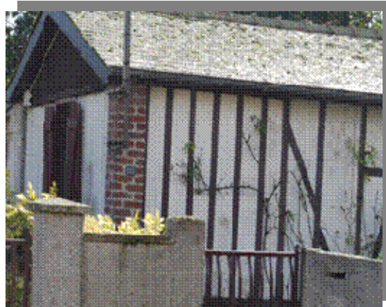
Figure 18 : Murs à ossature bois et remplissage en torchis ou moellon enduit (Source : CETE NC, INERIS)
