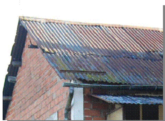
Figure 33 : Grands éléments de couverture : Tôles (Source : CETE NC, INERIS)
