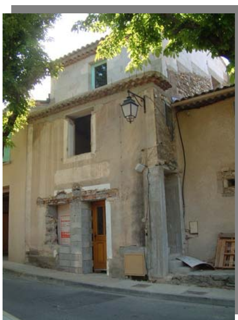
Figure 24 : Mur de façade mixtes (Source : CETE Méditerranée)
