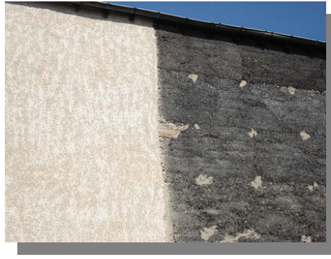
Figure 21 : Exemples de murs en pisé (Source : INERIS)
