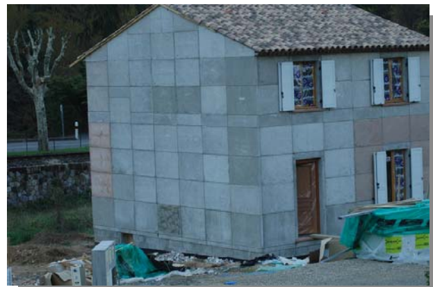
Figure 4 : Maison individuelle en béton armé (préfabriqué) (Source : CETE Méditerranée)
