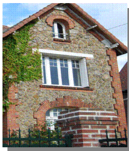
Figure 15 : Murs en moellons bruts lités (à gauche) ou moellons pour « opus incertum » (à droite), encadrements de fenêtres en briques (Source : CETE NC, INERIS)
