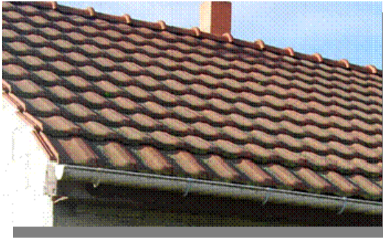
Figure 30 : Petits éléments de couverture : tuiles mécaniques terre-cuite ou béton (Source : CETE NC, INERIS)
