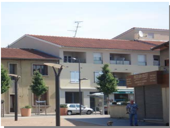
Figure 3 : Petit collectif en béton armé (Source : INERIS)
