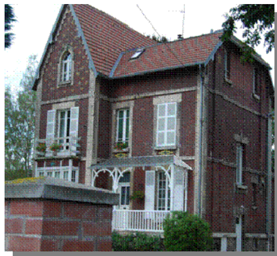
Figure 9 : Construction briques pleines, angles et niveaux de planchers mis en valeur avec des pierres (Source : CETE NC, INERIS)
