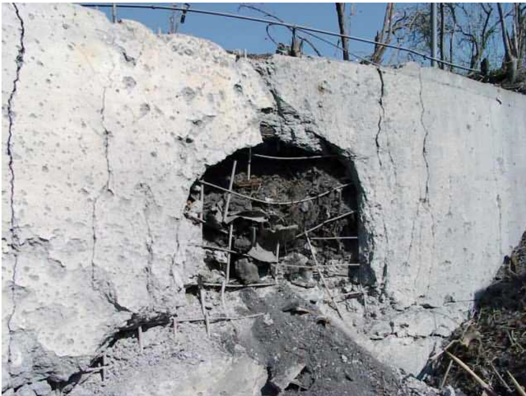
Figure 5 : Vue du mur de l'atelier 50 du site de Nitrochimie
