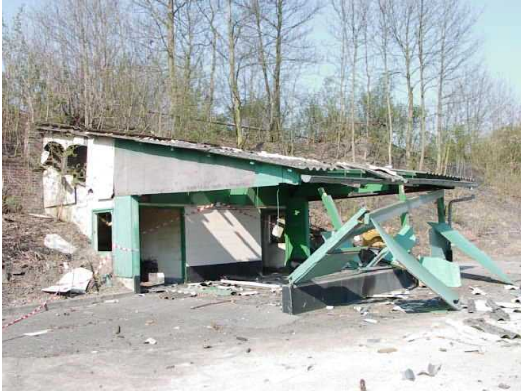
Figure 8 : Vue du bâtiment 57 du site Nitrochimie depuis un point situé à 60 m à l'Ouest de l'atelier 50
