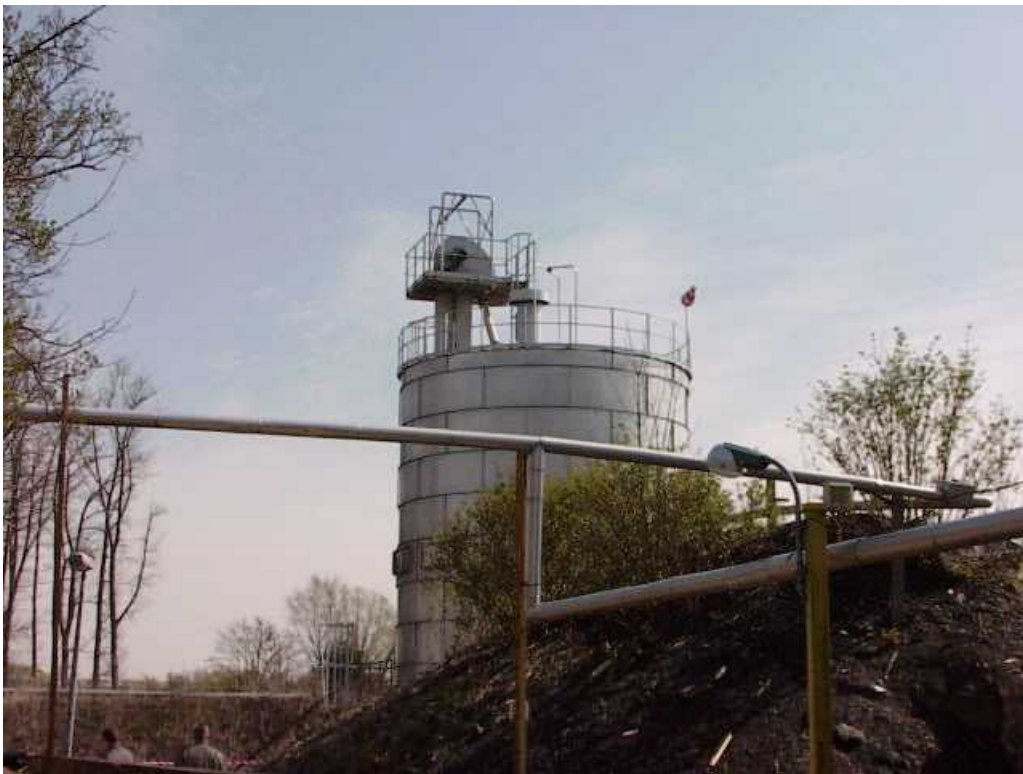
Figure 9 : Vue du stockage 32 du site Nitrochimie depuis un point situé à 65 m au Sud-Est de l'atelier 50
