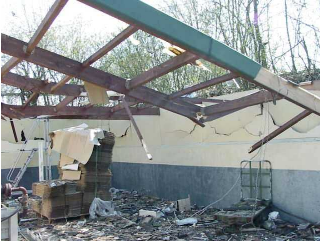
Figure 6 : Vue de l'atelier 52 du site de Nitrochimie depuis un point situé à 20 m au sud de l'atelier 50 (de l'autre côté du merlon)
