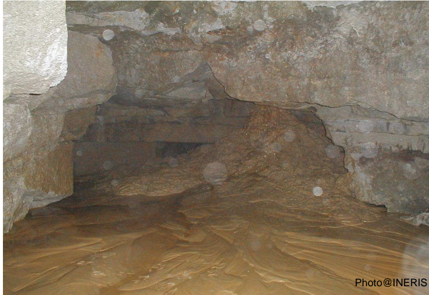
Figure 11 : Comblement par coulis de silicates
