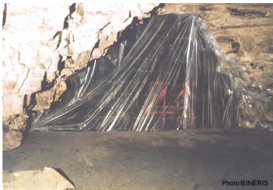
Figure 18 : Barrage de confinement en souterrain
