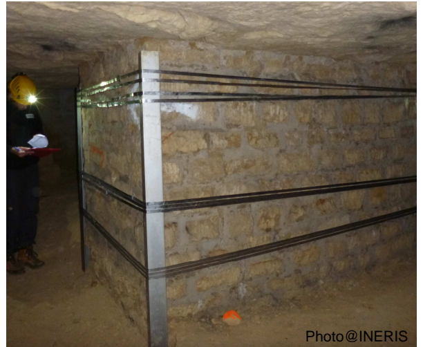
Figure 7 : Cerclage-ceinturage d'un pilier
