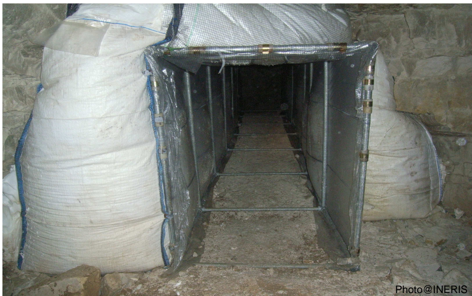
Figure 12 : Tunnel édifié à travers la mousse expansive pour maintenir un passage
