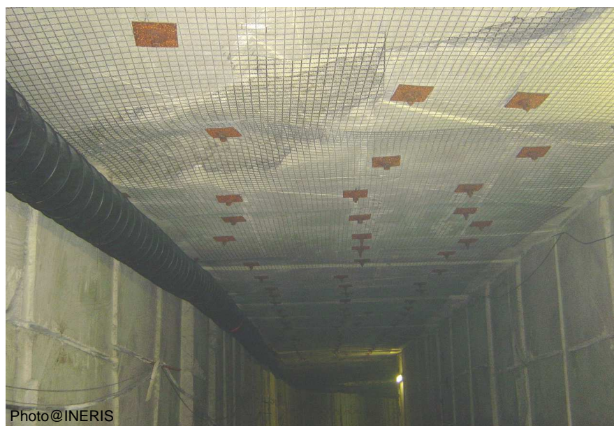
Figure 5 : Boulonnage du toit d'une galerie
