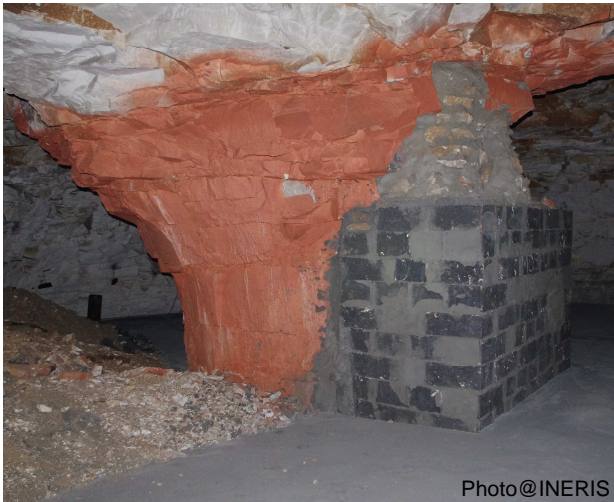
Figure 6 : Reprise d'un pilier par maçonnerie
