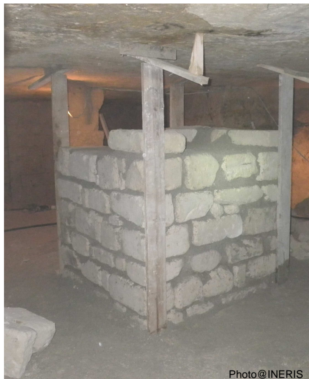
Figure 8 : Construction d'un pilier maçonné
