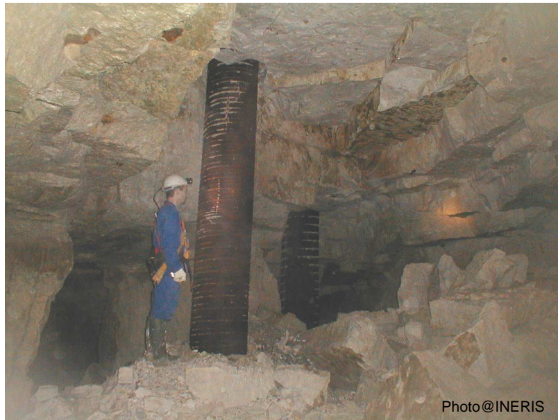
Figure 15 : Pieu traversant une cavité
