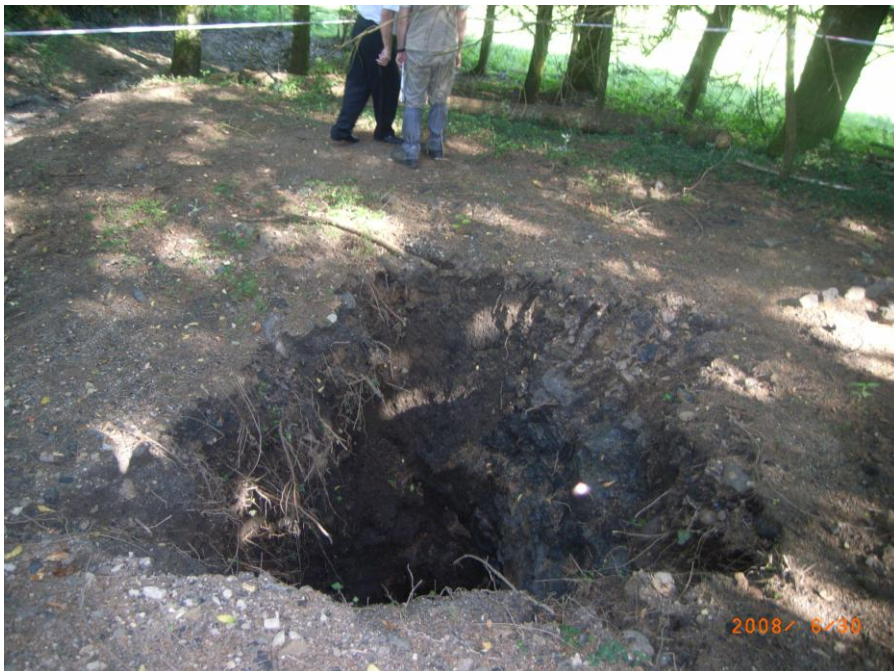
Photo 1 : Effondrement aux bords francs, survenu au droit de travaux à faible profondeur (Mine de charbon de Bosmoreau) (Source : INERIS)
