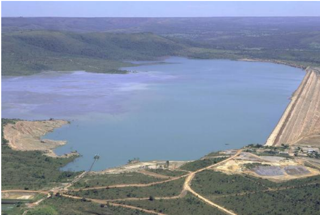
Figure 1 : Barrage minier de Rio Paracatu Mineração, exploitation d'or au Brésil, [8].
