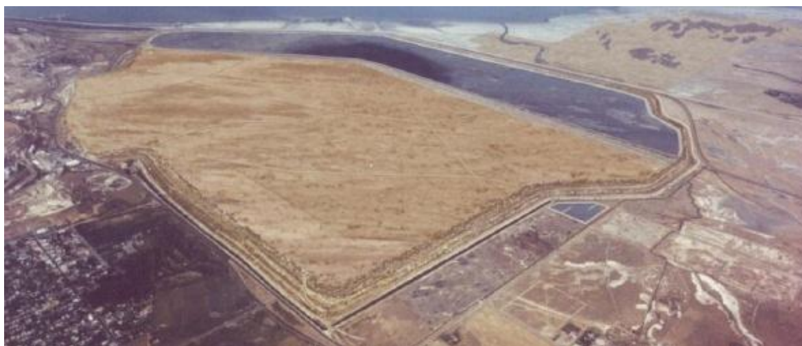
Figure 7 : Bassin de rétention annulaire de Bingham Canyon, exploitation de cuivre aux USA, tirée de [8].
