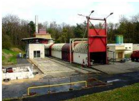
Galerie à incendie de 50 m pour réaliser des essais de combustion jusqu'à une puissance dégagée de 10 MW (en maîtrisant les rejets dans l'atmosphère par une « tour de lavage »)
