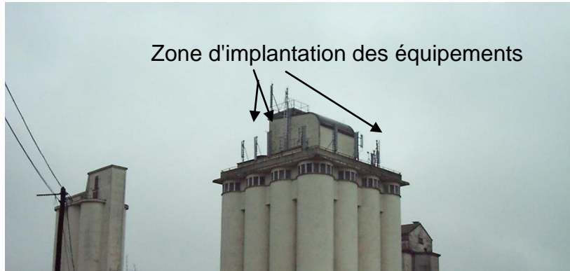
photo 1: vue générale du silo
