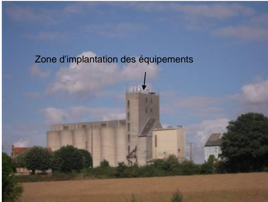
photo 2: vue générale du silo
